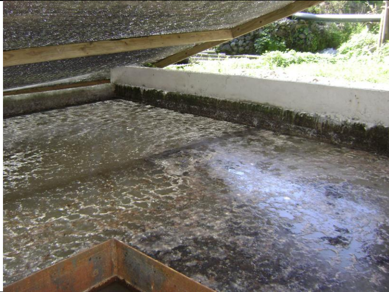
Fotografía 20. Cámara de lodos Sistema de Riles Loncostraro.
