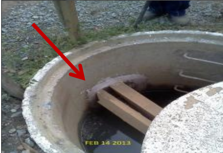
Fotografía 14, 15. Modificación y rectificación en cámara 1
