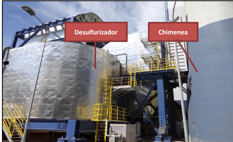
Fotografía 8: Construcción del Desulfurizador - Unidad 1.
