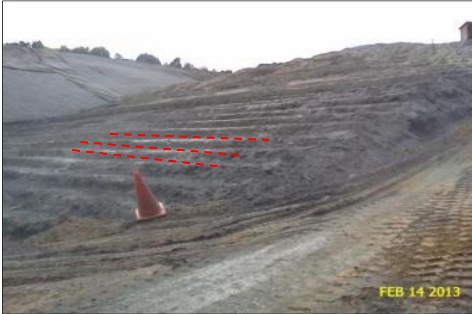
Fotografía 17: Registro de ingreso a Vertedero de Cenizas.
