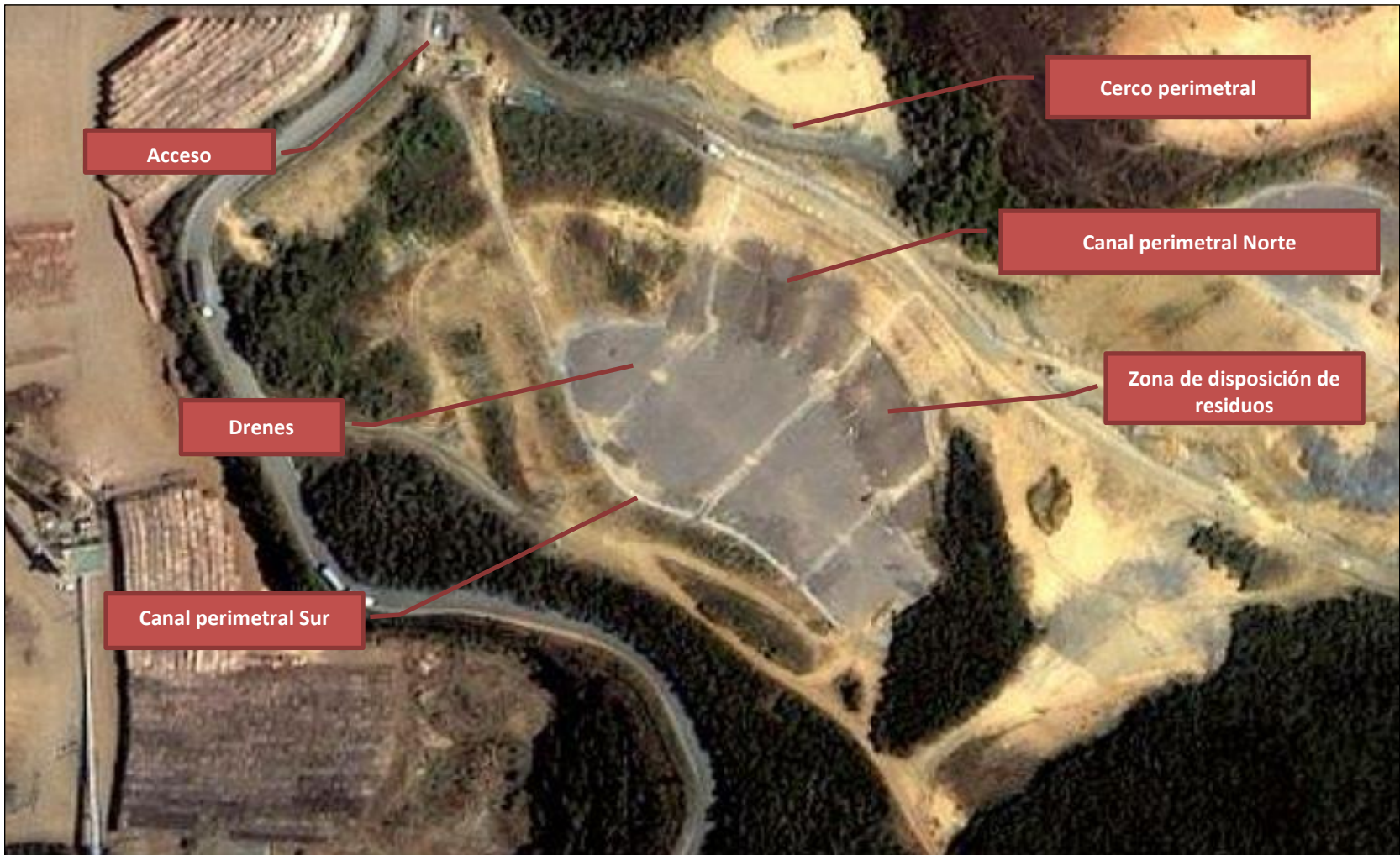
Imagen 4. Vertedero de Cenizas Bocamina (Fuente: Elaboración propia en base a imagen ArcGis Explorer, 2013).
