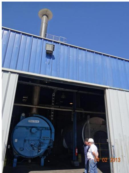
**Fotografía****Fecha:** 02-04-2013**Coordenadas WGS84****Norte:** 6.240.549**Este:** 343.950**Descripción Medio de Prueba:** en Fotografía se aprecia galpón de calderas y en primer plano caldera recientemente instalada.
