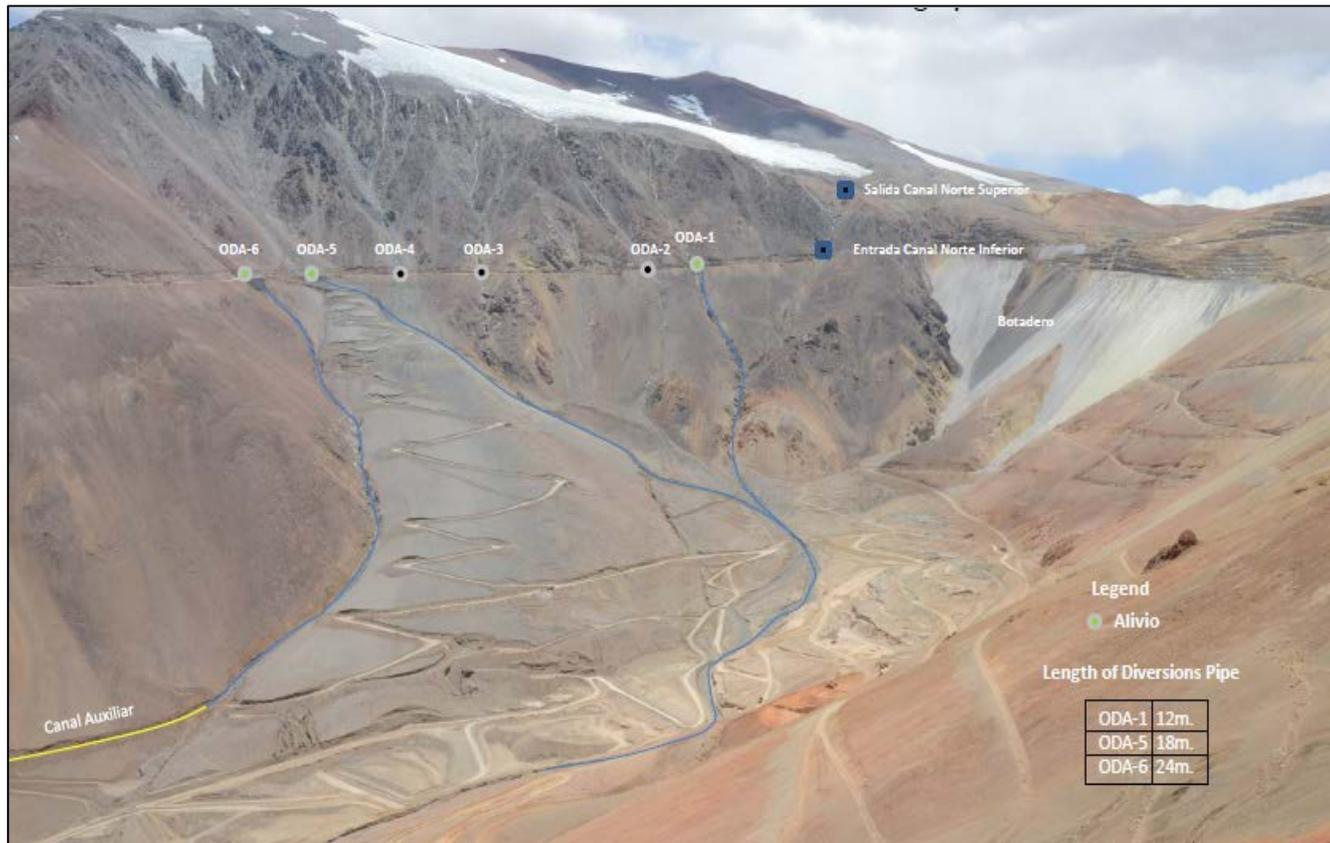
Figura N° 4. Vista de sistema de manejo de aguas de contacto y no contacto (Fuente: Barrick, 2013)
