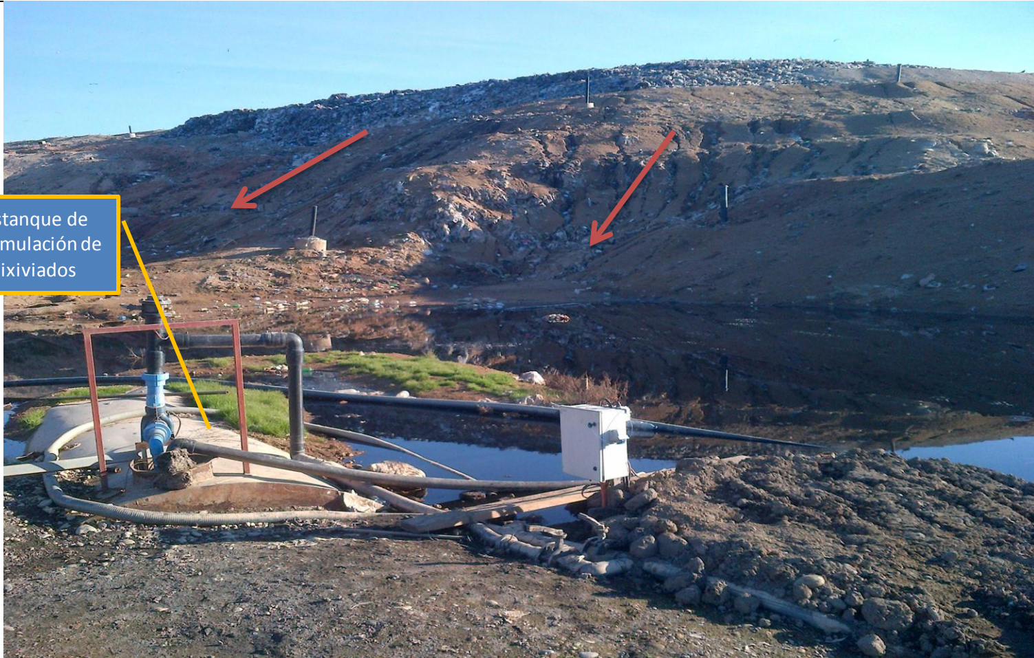
Figura 22. Fecha : 13-06-2013 Coordenadas WGS84 Norte: 5.917.973 Este: 691.057 Descripción de Medio de Prueba: La fotografía muestra la segunda área de acumulación de aguas lluvias con lixiviados, al pie de la etapa 2 del relleno sanitario en operación. Las flechas muestran la dirección del escurrimiento de lixiviados observado por los fiscalizadores. Se observa estanque de acumulación de lixivado enterrado.
