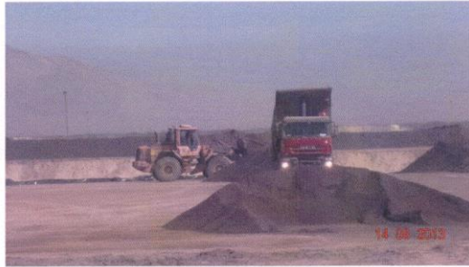
Vaciado de Ripio en el sector de pila de lixiviación de óxidos.
