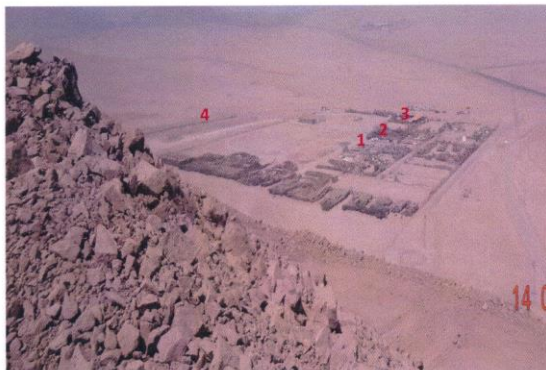
Panorámica Patio de Salvataje, Residuos Peligrosos y Zanja Residuos domésticos y asimilables.
