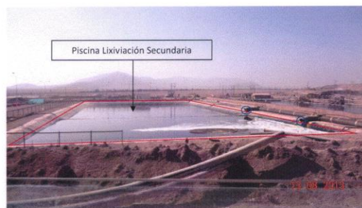
Zona de Descarga del lixiviado a la Piscina de la Lixiviación Secundaria.
