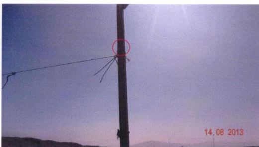
Sistema de Control de altura de las pilas de lixiviación de sulfuros, a los 2.50 metros.
