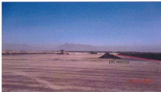
Pilas de Lixiviación Primaria de Óxidos, se visualiza la construcción de un panel de la pila de lixiviación. Esta está construida con una pendiente de escurrimiento hacia el sector donde se ubica la maquinaria pesada (Cargador Frontal), la cual va dirigida hacia la canaleta con una pendiente hacia el sector izquierdo de la imagen. WGS 84 N. 7.491.059 E. 377.743
