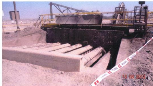
Tolva recepción de Compra en mantención. WGS 84 N. 7.490.981 E.378.709
