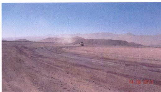
Botadero Norte de Estériles del Rajo Lince, WGS 84 N. 7.492.438 E. 379.339 C. 855msnm . Esta es la parte más alta del botadero norte, se realizó la construcción de plataformas cada 10 metros.
