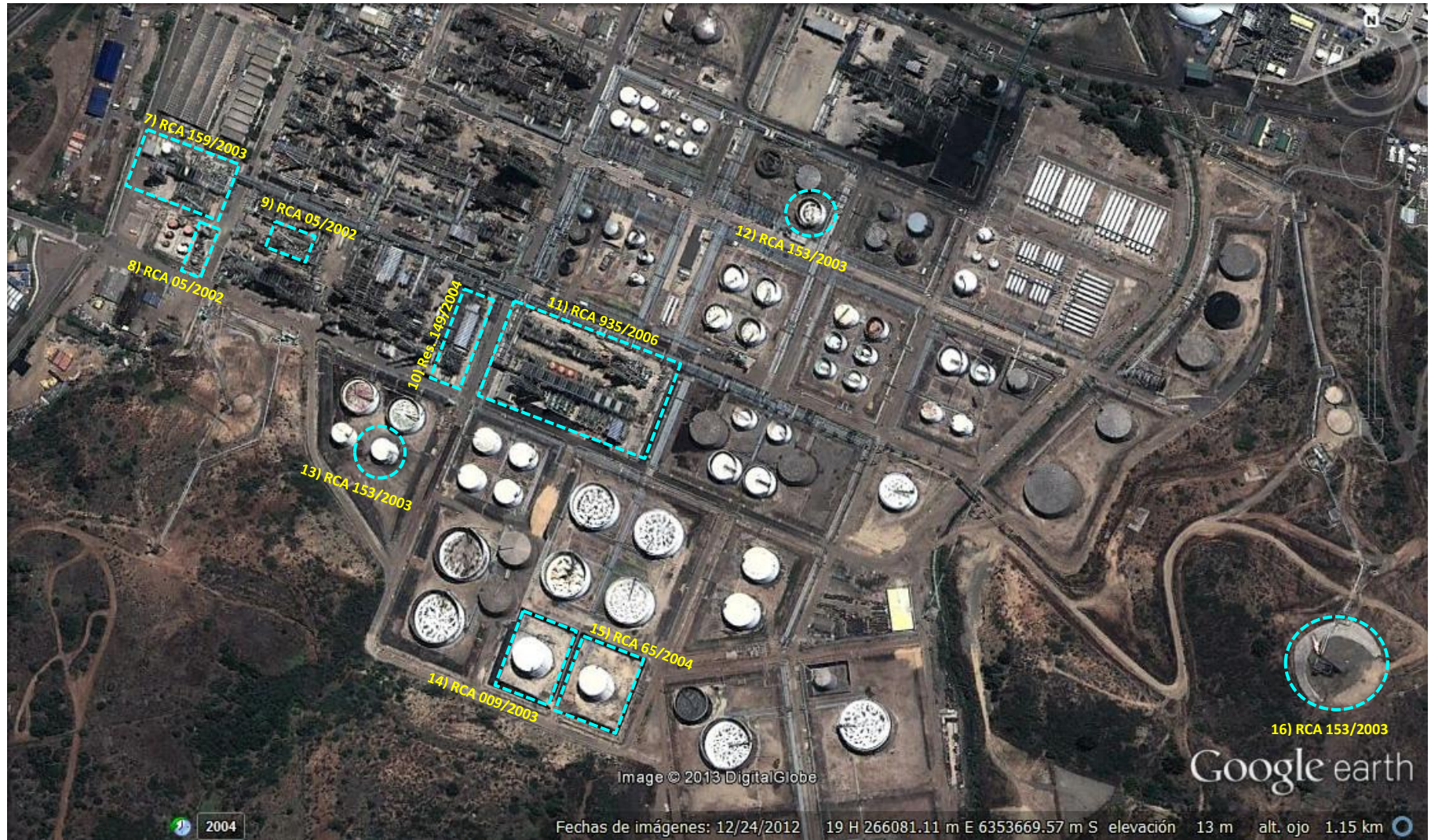
Figura 4. Localización de proyectos con RCA fiscalizados al interior de Refinería Aconcagua – Sector Sur (Fuente: Google Earth, 2013).
