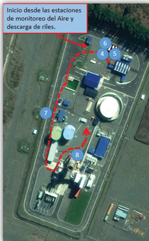
Figura 5. Detalle de estaciones de recorrido en la Central Termoelectrica Santa Lidia (Fuente: Elaboración propia con NEPAssist/SMA).
