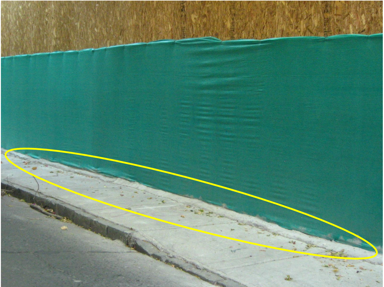
Imagen 2. Barrera perímetro obra con sello inferior.
