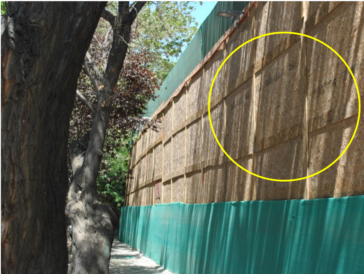
Imagen 1. Barrera perímetro obra con sellos entre placas.
