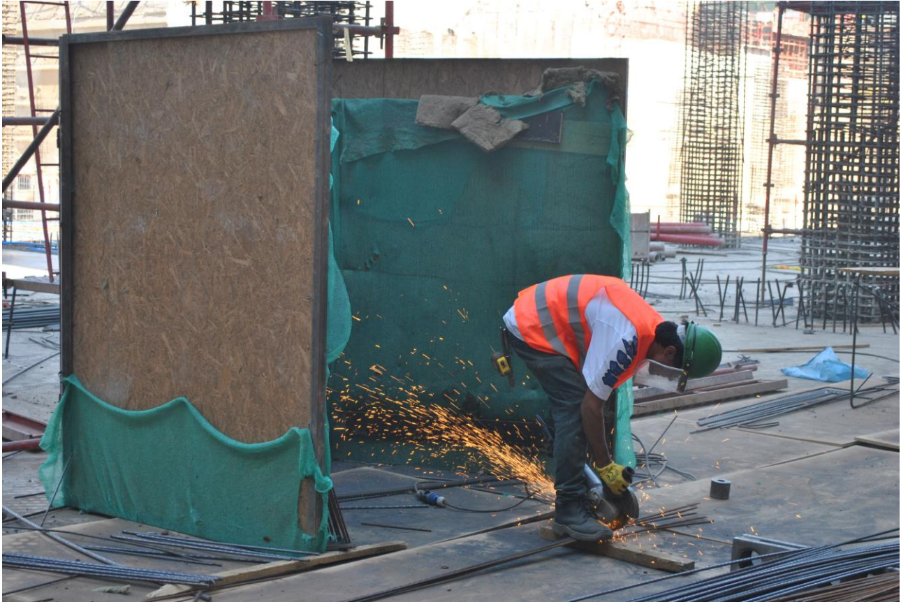
Imagen 5. Barrera existente para corte de materiales.
