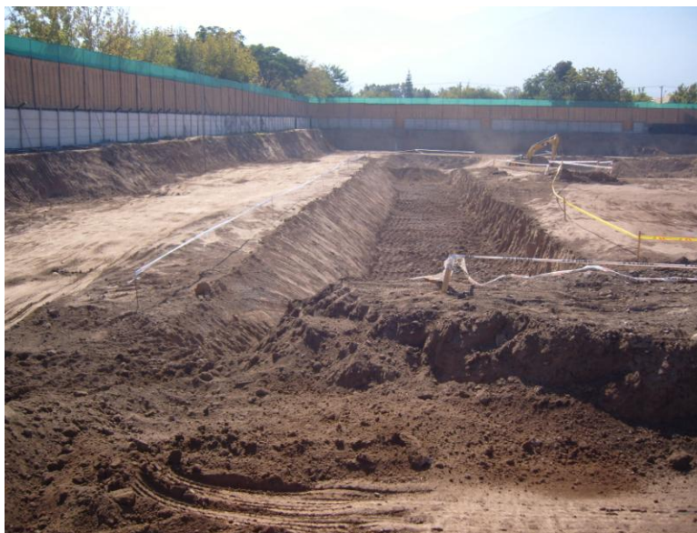
Foto Nº 6 Inspección visual desde la superficie (piso de tránsito) hasta los 3.50 mt Izquierda: Talud y la excavación hasta los 3.50 mt. Centro: Talud y Profundización bajo los 3.50 mt. Derecha: Excavación hasta los 3.50 mt.
