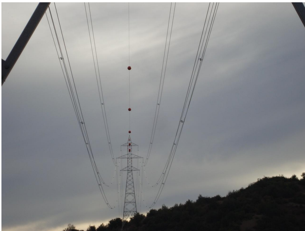
Foto 3. Instalación de balizas entre estructura 38 – 39, cruce quebrada, sector El Durazno.
