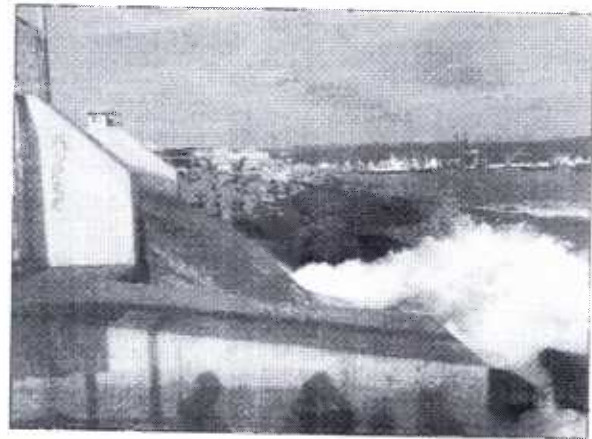
Fotografía 7: Ducto de evacuación.
