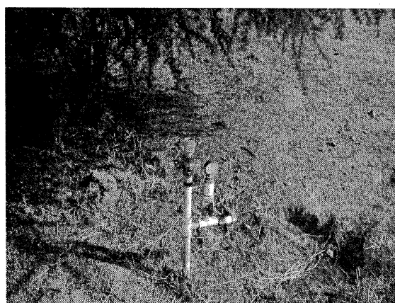
Foto 21 detalle de equipo aspersión, falta el extremo superior (aspersor) no se evidencia aplicación
