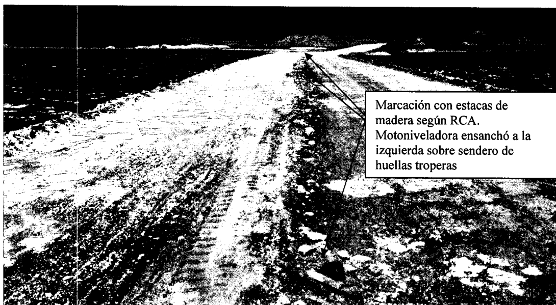
Figura 3. Foto específica de los 96 metros intervenidos donde muestra las estacas que estaban demarcando el lugar de no intervención
