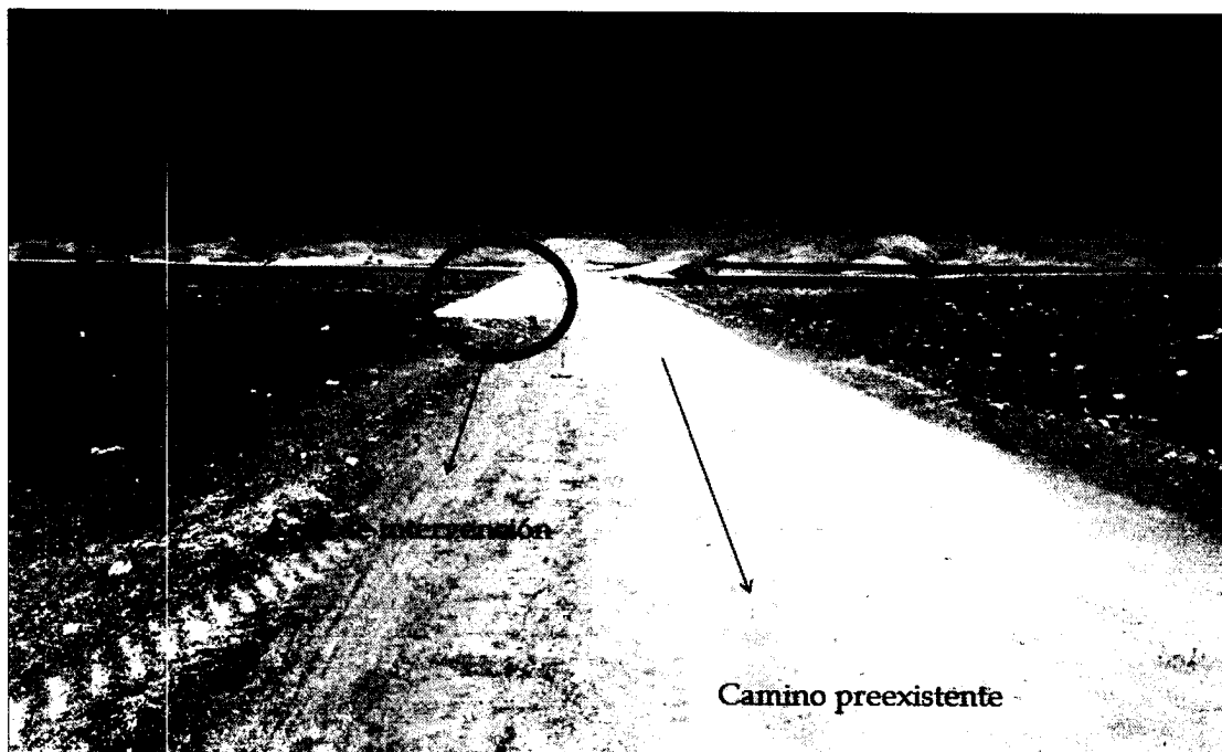
Figura 2. Terraplén del gasoducto, el camino pre-existente, el área de intervención del 96 metros de largo y el estacado existente para ese sendero tropero 1-2
