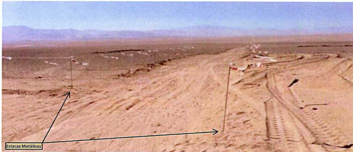
Figura 4. Estacas metálicas en la intersección del eje 1 y 21.
