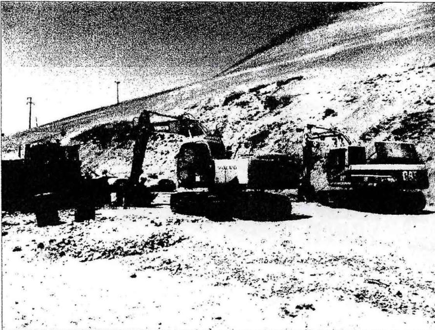
Fotografía 2: Maquinarias trabajando para el despeje del terreno para formar la plataforma
