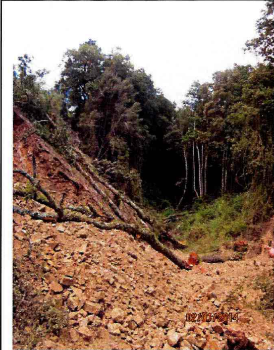
FOTO 1: Muestra tala de bosque nativo en área de protección de estero de aguas permanentes. Terrenos susceptibles de erosión hídrica. Coordenada UTM WGS84: 678551-5929456
