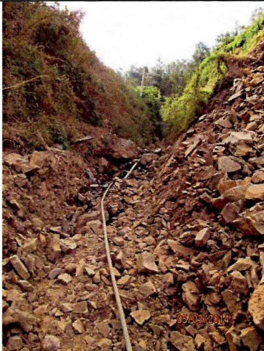
FOTO 7: Estero de aguas permanentes es gravemente alterado por la eliminación de la vegetación protectora. Se aprecia alteración de cauce con movimiento de tierra y desvío de curso de agua a través de tubo. Coordenada UTM WGS84: 678769-5929431.
