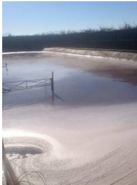
Fotografía 4: Piscina de aireación
