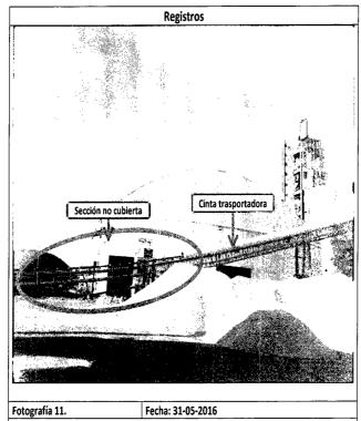
**Descripción Medio de Prueba:** Cinta que transporta la caliza desde el sector de materias primas hacia el edificio de tolvas de crudo. Se pude apreciar en que parte de esta no se encuentra cubierta.
