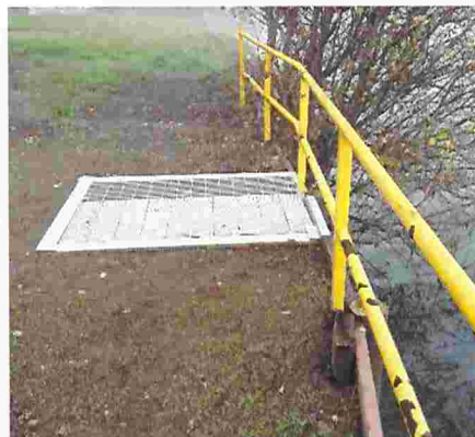
Fotografía N°2: Nueva descarga que consiste en una cañería de efluentes ubicada en el predio de la instalación, con descarga al río Calle Calle, sin obras en el cauce.
