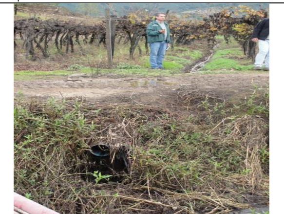
Figura N° 22: Descarga de residuos líquidos hacia canal de riego. En la imagen es posible ver la canalización de residuos líquidos y la tubería que atraviesa el camino hasta el canal de riego.
