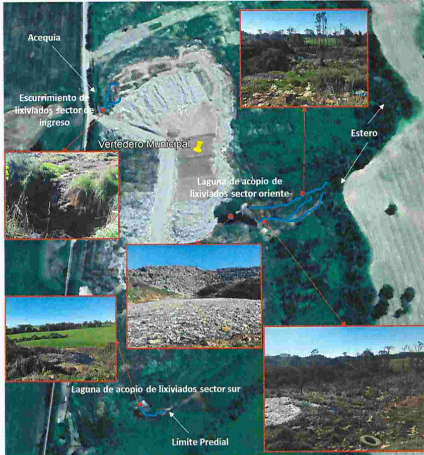
Imagen N°6: Acumulaciones y escurrimiento de lixiviados constatados.
