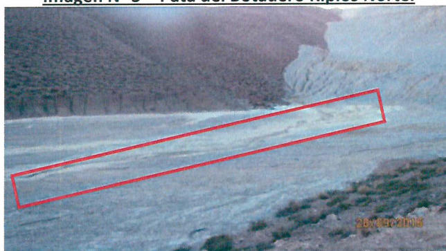
Imagen N° 5 – Pata del Botadero Ripios Norte.
