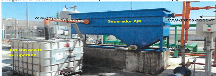
Imagen N°2: Estanque separador API y bin de descarte de aceites y grasas.
