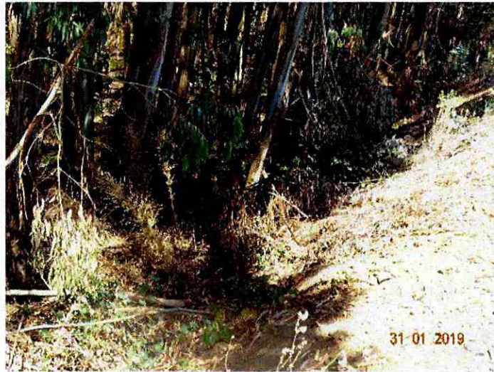
Imagen N° 2 – Inexistencia de cerco perimetral en sector sur del predio
