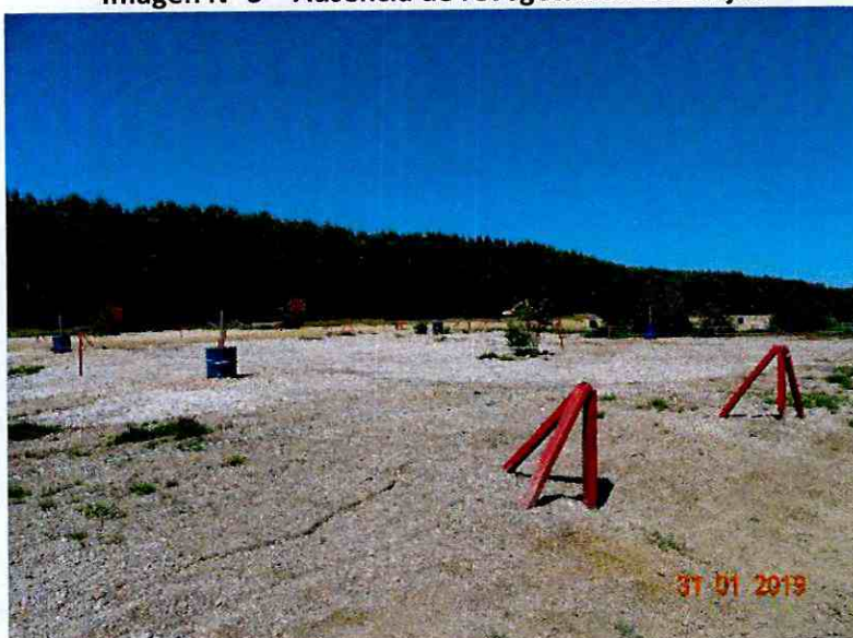
Imagen N° 3 – Ausencia de revegetación de zanjas
