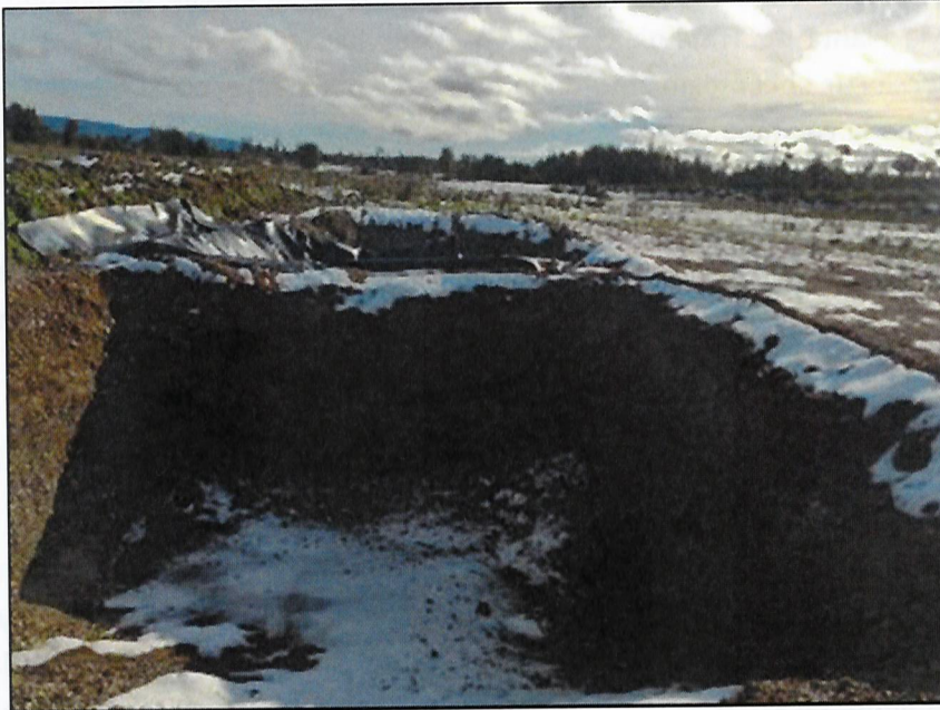
Fotografía 1: pozo a la intemperie (al frente) y pozo impermeabilizado (atrás)
