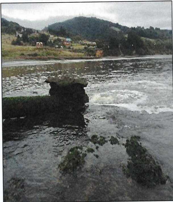
Fotografía 4: lugar de descarga del emisario
