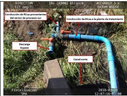
Imagen 4: Cruce soterrado que conecta el canal sur con el canal norte, por debajo de la Ruta K-156. Se puede observar la tubería de conducción de riles de PVC utilizada para trasladar riles.
