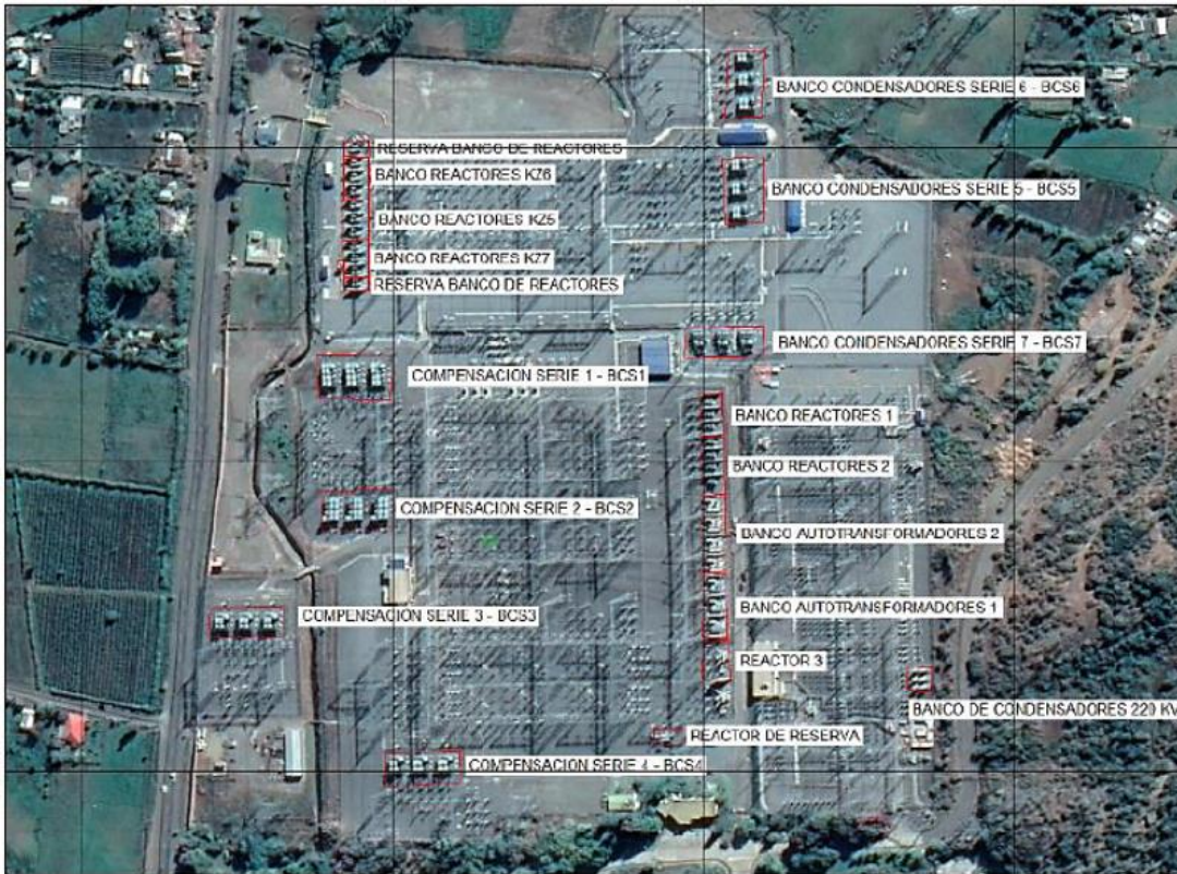
Imagen 1. Emplazamiento de la unidad fiscalizable “Subestación Ancoa”.
