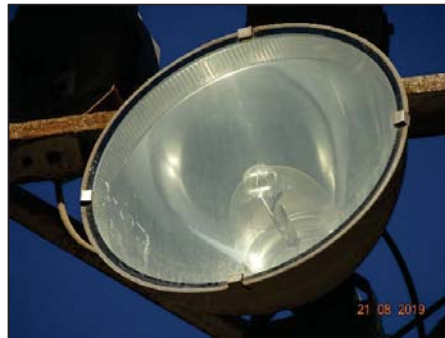
Fuente: Informe de Fiscalización DFZ-2019-2333-IV-NE, Fotografía 1.
