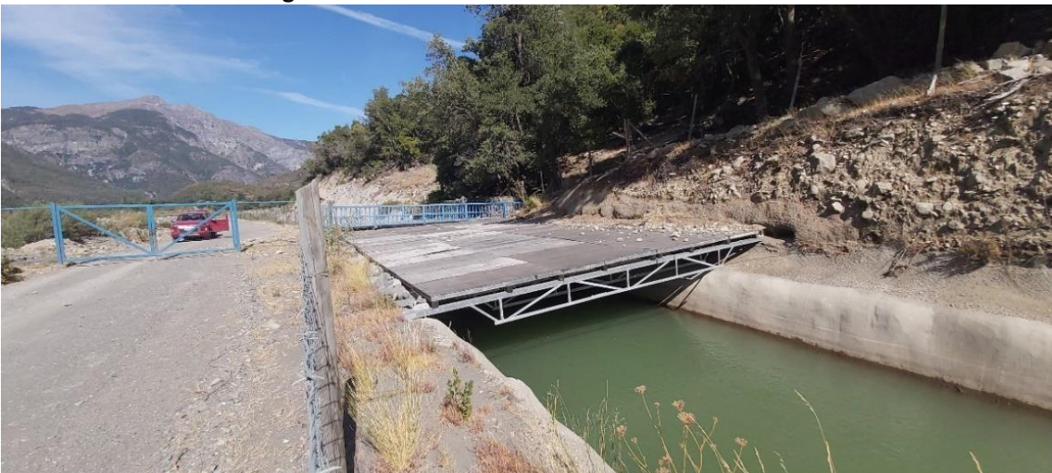
Figura 1. Tramo abovedado del canal de aducción
