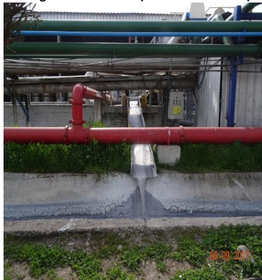
Imagen 2. Punto N° 1 (Sector Clarificador)
