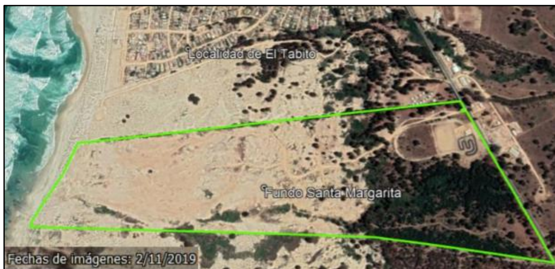
Imagen N°14: Fundo Santa Margarita, situación de las dunas intervenidas por la extracción de áridos, año 2019, evidenciándose alteración en su superficie y geomorfología con respecto a las dunas de la localidad de El Tabito, ubicadas al norponiente del Fundo Santa Margarita. Fuente: DFZ-2018-2494-V-SRCA, pg. 32.
