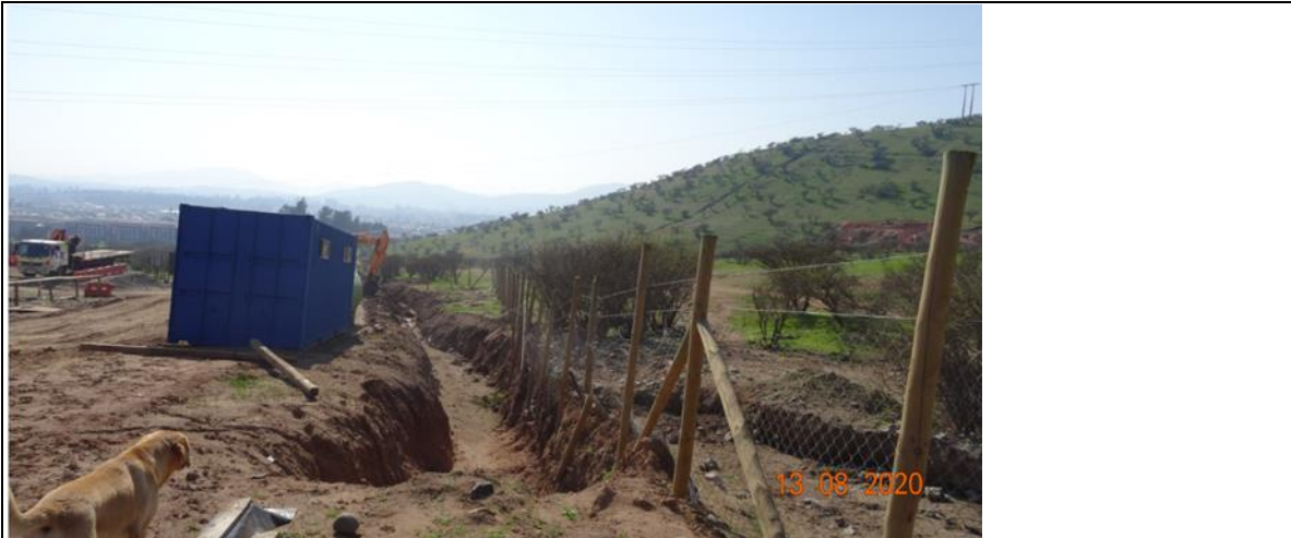
Fotografía 1. Sector de inicio de la zanja construida por la empresa una vez ocurridos los eventos de precipitación de junio
