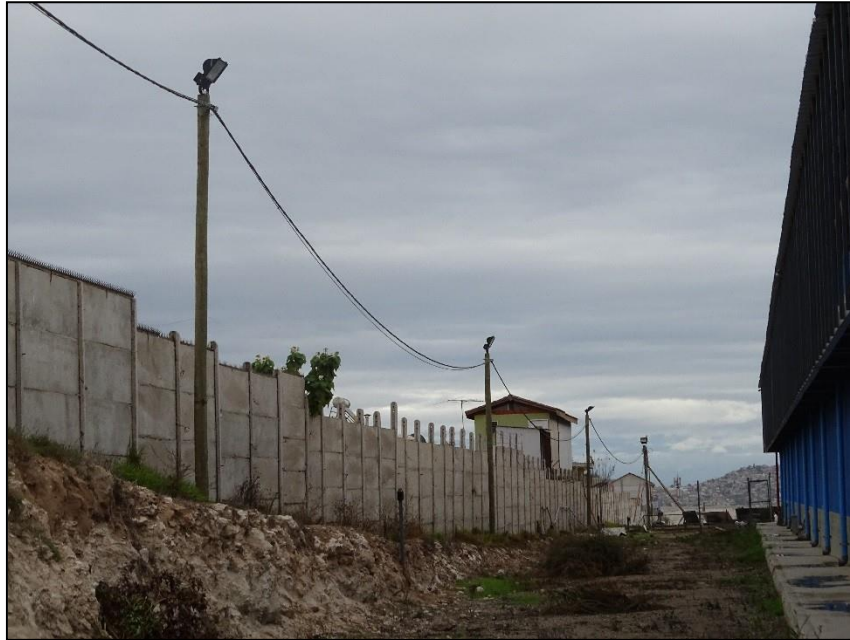
Imagen 6. Vista general Luminaria N° 7, sector calle de servicio
