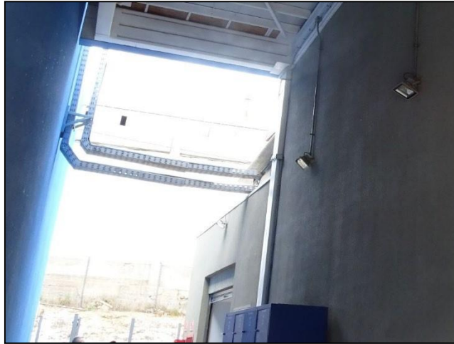
Imagen 4. Vista general Luminaria N° 5, sector fuera del baño de clientes
