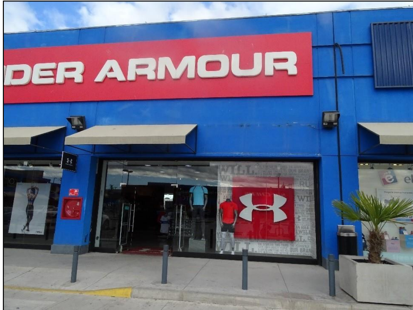
Imagen 2. Vista general Luminaria N° 2, sector pasillo, para el alumbrado de clientes.
