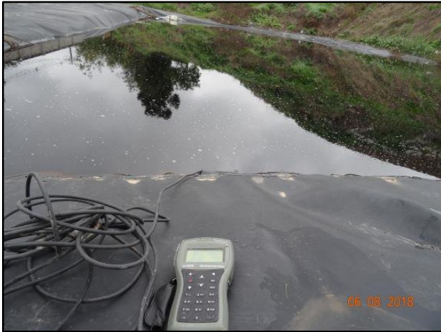
Figura N°12: piscina de lixiviados norte con rebalse de líquidos lixiviados. Fuente: DFZ--2018-1523-IX-RCA, pp. 39.
