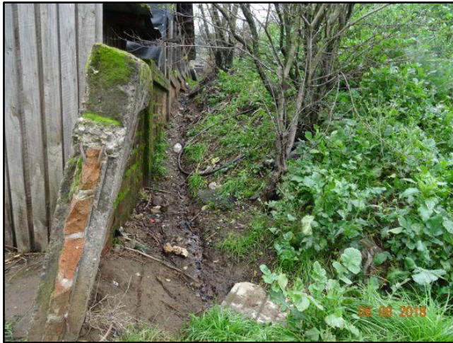
Figura N°17: flujo de lixiviados en cerco que divide internamente en sector norte y sur del Vertedero Angol.
