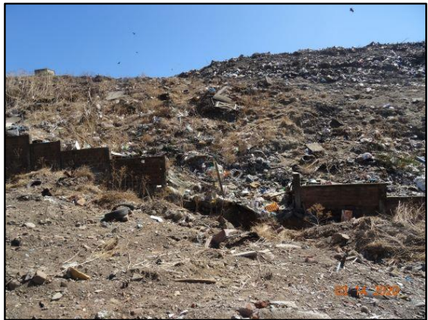
Figura N°1 y N°2: cerco divisor sector norte y sur del interior del Vertedero Angol sobrepasado por presión de residuos provenientes del frente de trabajo. Fuente: DFZ--2018-1523-IX-RCA, pp. 19.
