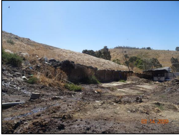
Figura N°16: escurrimiento de lixiviados hacia sector de acumulación de lixiviados en sector de taller de mantención de maquinarias.
