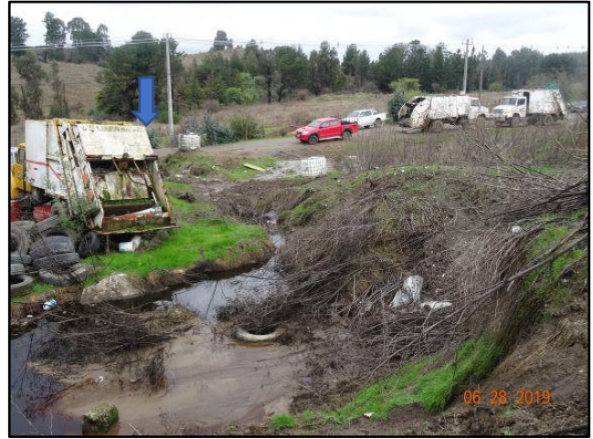
Figura N°13: acumulación de líquidos percolados en sector de talleres de mantenimiento, cuyo rebalse se conduce al canal de aguas lluvias en sector indicado con la flecha. Fuente: DFZ--2018-1523-IX-RCA, pp. 40.
