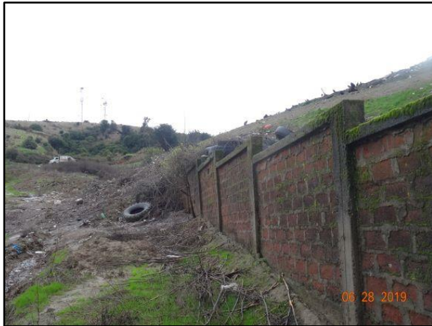
Figura N°1 y N°2: cerco divisor sector norte y sur del interior del Vertedero Angol sobrepasado por presión de residuos provenientes del frente de trabajo. Fuente: DFZ--2018-1523-IX-RCA, pp. 19.
