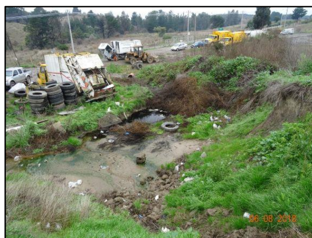
Figura N°15: sector de acumulación de lixiviados en lugar sin impermeabilización que descarga hacia canal de aguas lluvias en punto más cercano a portón de ingreso del Vertedero Angol. Fuente: DFZ--2018-1523-IX-RCA, pp. 45.
