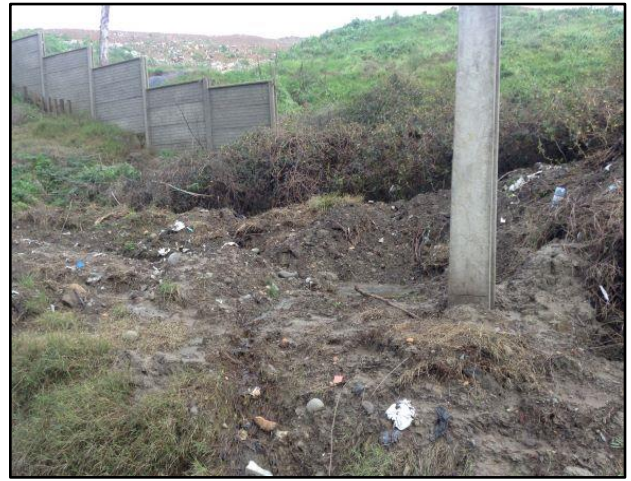
Figura N°18: exterior de rebalse de piscina de lixiviados sector norte de Vertedero Angol.
