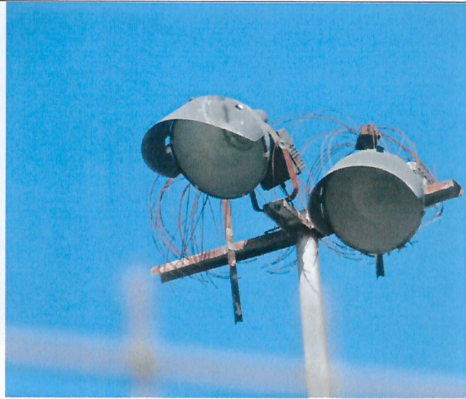
Imagen 4. Detalle luminaria canchas de futbolito, se observa la visera con aberturas (Luminaria 2).
