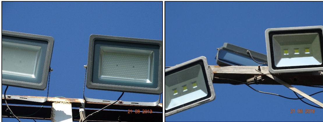
Imagen 2. Luminarias LED Logic 066-150W de 150 W en color negro (Luminaria 2, izquierda) y Luminaria LED de 3 celdas (Luminaria 3, derecha).
