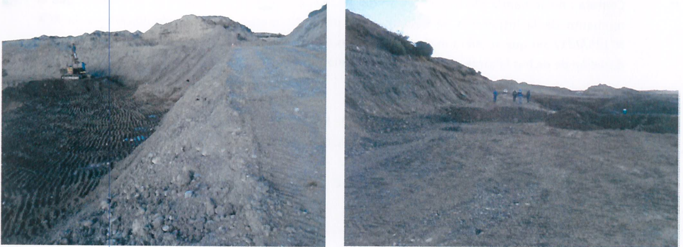
Imagen 4 y 5. Taludes con ángulo superior a 45° e inexistencia de canales perimetrales para conducción de aguas lluvias, respectivamente.
