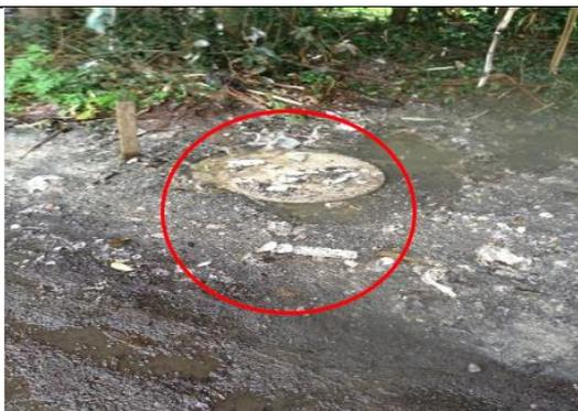
**Imagen 5.** Cámara de aguas servidas en las afueras de la PTAS, donde se constató el escurrimiento de aguas servidas sin tratar (coordenadas Norte: 6.092.590; Este: 293.345)
