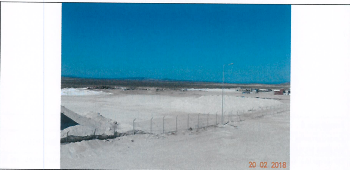
Imagen N° 2: Acumulación de residuos en sector Planta Cal
