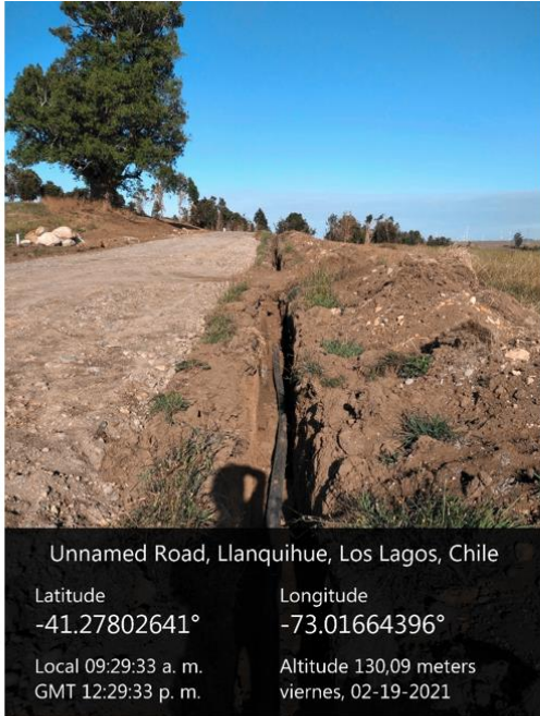
Fotografía 3. Fecha: 19-02-2021 Fotografía 4. Fecha: 19-02-2021 Descripción del medio de prueba: Canalización subterránea del agua, se observa tubería y montículos de tierra al costado. Descripción del medio de prueba: Vista desde la parte alta del estado de la canalización subterránea de agua, nótese como referencia basal esta fotografía, montículos de tierra, para las inspecciones del 25 de febrero y 02 de marzo de 2021.
