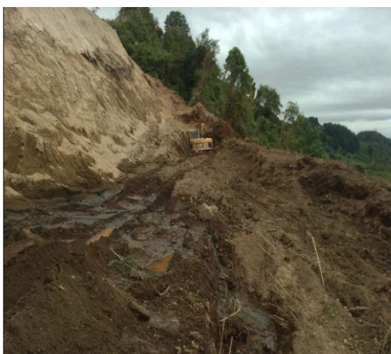
Fotografía 3. Fecha: 24-12-2020 Descripción del medio de prueba: Maquinaria de la Constructora Stange trabajando en el sector intervenido.
