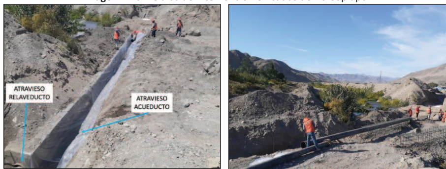
Imagen N° 6 – Obras de intervención en cauce de río Copiapó
