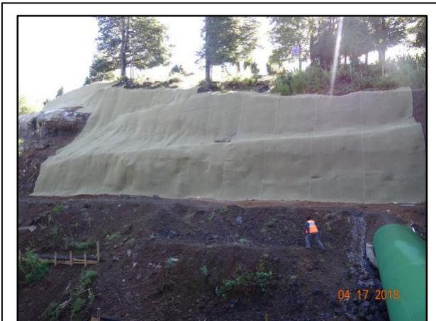
Imagen N° 2: sector tubería de aducción Carilafquén, en donde se puede ver el atraveso de la tubería descubierta que pasa por una quebrada y la colocación de malla en la pendiente del talud, para contener el desprendimiento de suelo.
