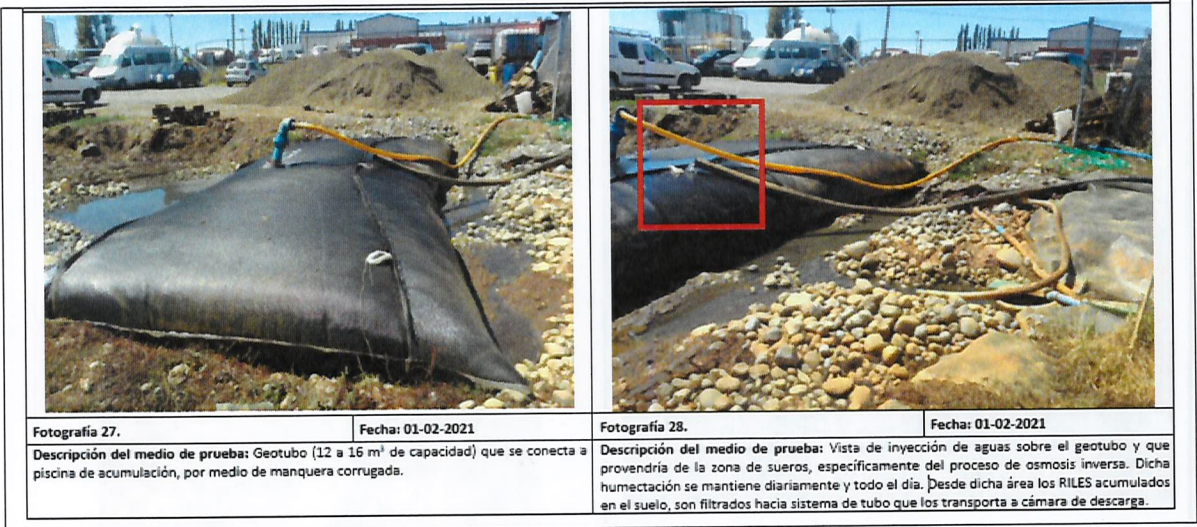
Imagen N° 7 y 8. Geotubo en inspección de 01 de febrero de 2021
