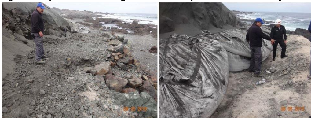
Figuras N° 3 y N° 4 – Tramos sin geo contenedores y tramo con sacos de baja altura
