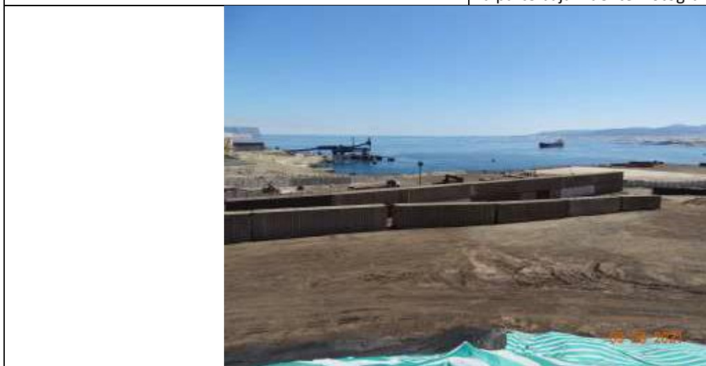
Imagen 3. Cerco perimetral frontal en base a containers . Este tipo de cerco no garantiza control de las emisiones provenientes del acopio. Fuente: Imagen 12, IFA MP.
