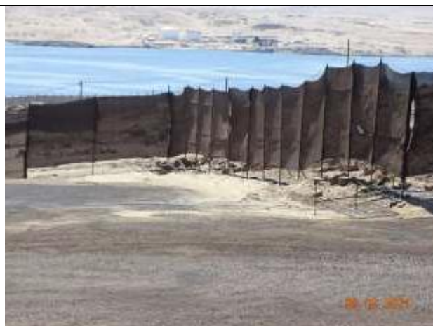
Imagen 2. Vista de la malla perimetral del acopio, área Noreste. Se observa un espacio aproximado de 1 metro en la parte baja. Fuente: Fotografía 8, IFA MP
