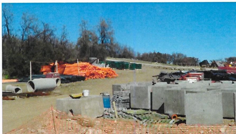
Imagen 2. Construcciones al interior de las 563,6 hectáreas comprometidas
