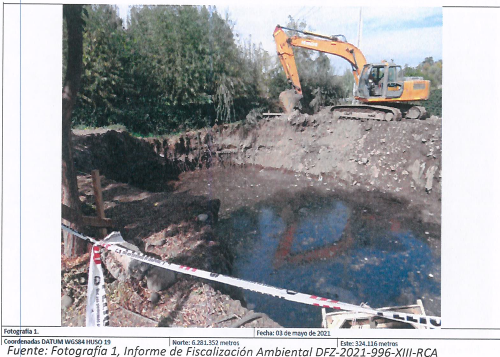
Imagen 2. Vista de la excavación realizada para instalar Torre 73.
