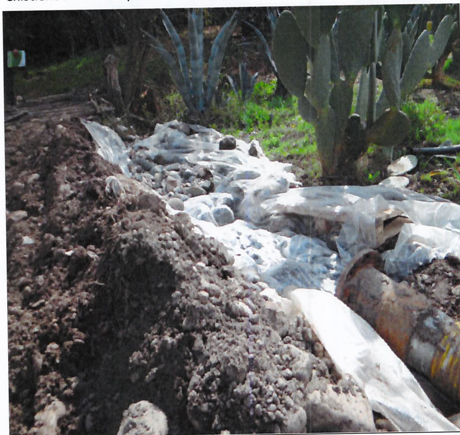
Imagen 11. Vista del punto donde se descargaron aguas afloradas, existiendo cubierta plástica con bolones.
