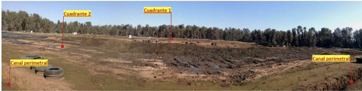
Fotografía 8. Cuadrantes de acopio y canal perimetral.
