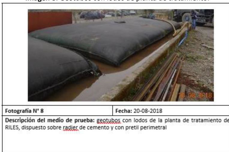
Imagen 8. Geotubos con lodos de planta de tratamiento.
