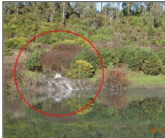
Imagen N° 6: ingreso de aguas servidas al sistema de tratamiento, donde se encuentran las rejas gruesas y finas para la retención de sólidos. Esta sección se encuentra tapada, circunstancia que permite que la descarga se realice sólo en una laguna.
