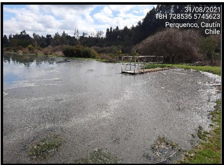
Imagen N° 34: conforme al nivel de cobertura de las lagunas, se aprecia que no es posible distinguir las tuberías de ingreso del efluente.
