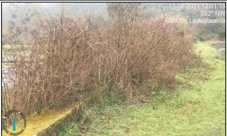
Imagen N° 11: ducto de colector de entrada que distribuye las aguas servidas hacia ambas lagunas, en el que se verifica la falta de despeje de dicho sector, evidenciando abundante maleza.
