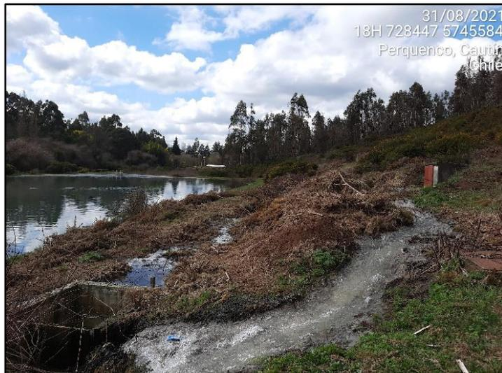
Imagen N° 33: escurrimiento de aguas servidas ladera abajo, producto de la obstrucción del sistema de rejas de la PTAS Perquenco.
