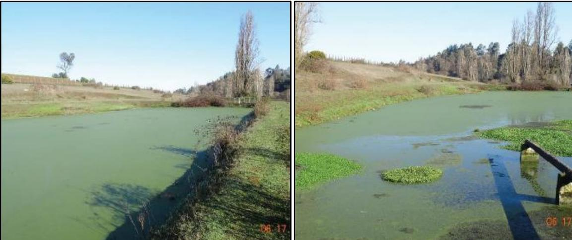
Imagen N° 8 y N° 9: laguna facultativa sector oeste, que no recibe aguas servidas, observándose formación en su superficie y coloración oscura.
