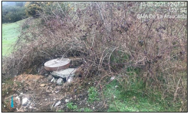
Imagen N° 13: zona de cámaras de alcantarillado interior con maleza que no ha sido removida y entorpece el acceso para la mantención de esta zona con evidencias de rebase.
