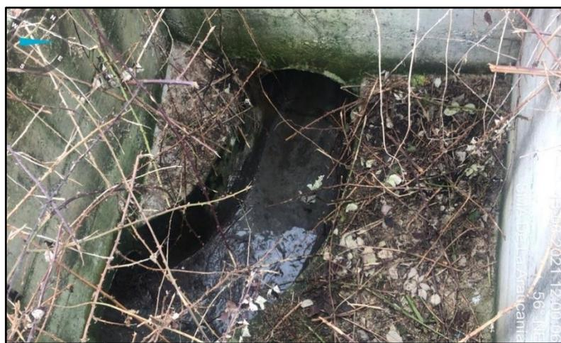
Imagen N° 18: zona de acceso de aguas servidas a la zona de pretratamiento, que evidencia sedimentos en banqueta y vegetación. Esta sección debe encontrarse en condiciones que permitan el libre escurrimiento de flujo de ingreso.
