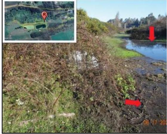
Imagen N° 5: existencia de lodo y aguas servidas apozadas en costado de laguna facultativa sector Este, con ocasión de rebalse de aguas servidas con lodos desde la laguna facultativa.
