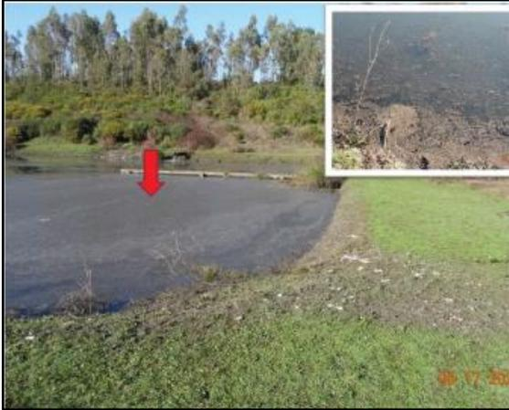
Imagen N° 4: existencia de lodo crudo acumulado en la superficie y en el fondo de la laguna facultativa, lo que provoca un foco de olores en la PTAS Perquenco. Esta laguna recibe toda la carga orgánica del sistema de tratamiento.
