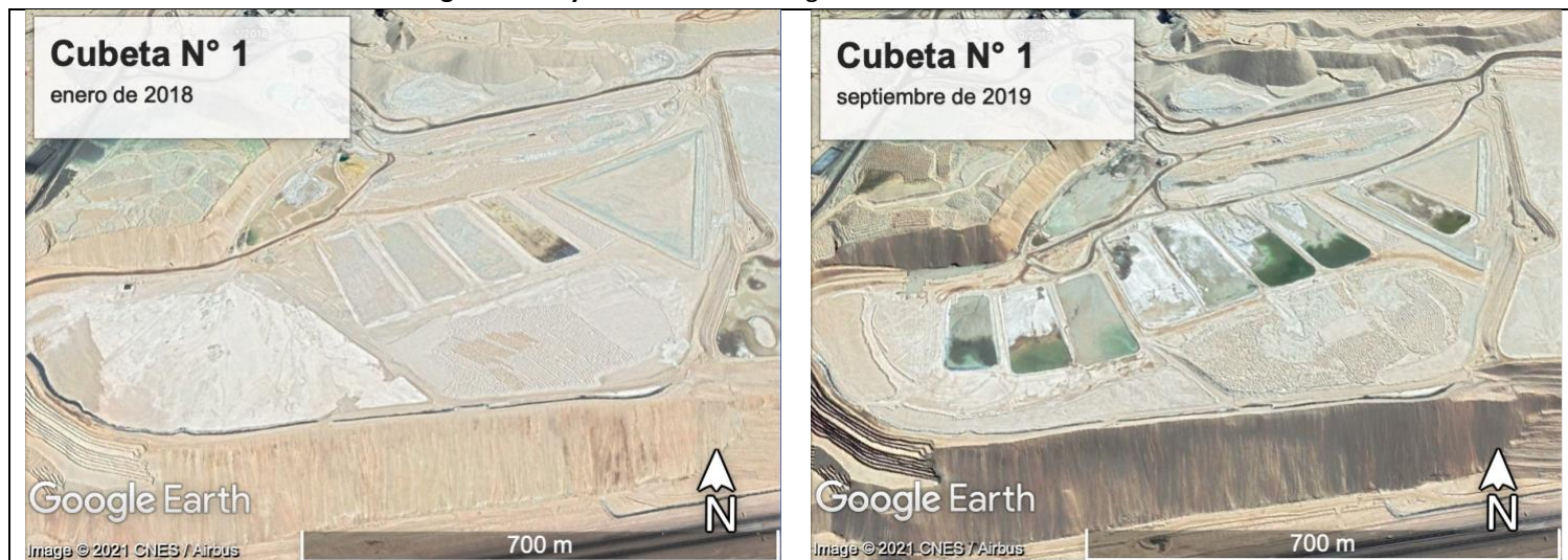
Imágenes N° 1 y 2. Piscinas de emergencia en cubeta de relaves N° 1
