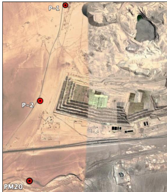
Figura N° 10. Ubicación de los pozos de monitoreo ambiental del Pit Fase 8
